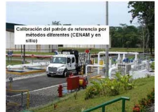
Figura 12. Fotografía de una instalación que combina un medidor de flujo másico de referencia y un probador para su calibración.
