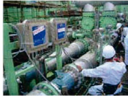
Figura 1. Medidores de flujo ultrasónico de 4 canales empleados en la comercialización del crudo mexicano.
