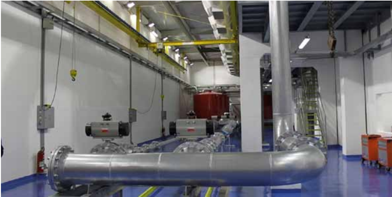
Figura 3. Vista parcial de la sección de prueba.
